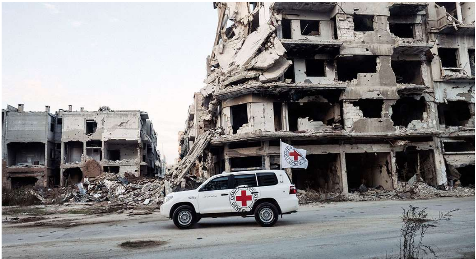
Photo des destructions dans le centre d'Homs, en Syrie. 25 février 2016 (Jérôme Sessini/Magnum Photos du CICR)
